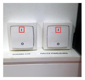
Les interrupteurs doivent être positionnés sur « I », si c'est le cas, passez à l'étape 5
