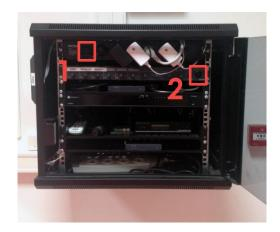
Le **bouton 1** doit être positionné sur «**1**» et le **bouton 2** en position **haute** avec une LED **bleue** allumée, si c'est le cas, <u>passez à l'étape 4</u>
